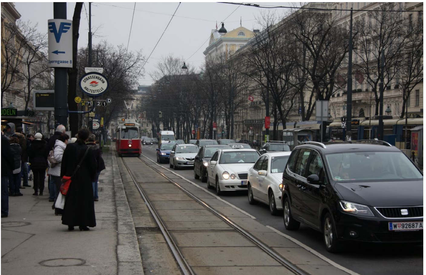
Torowisko tramwajowe odseparowane od ruchu samochodowego. Wiedeń (Austria) fot. T.Bużatek
