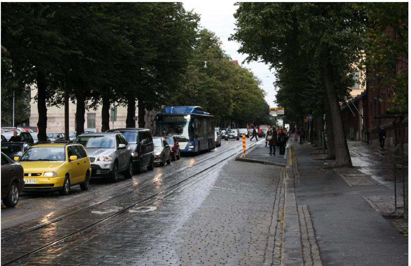
Platforma przystanku tramwajowego dosunięta do pojazdu i zwężająca jezdnię. Helsinki (Finlandia) fot. T.Bużatek
