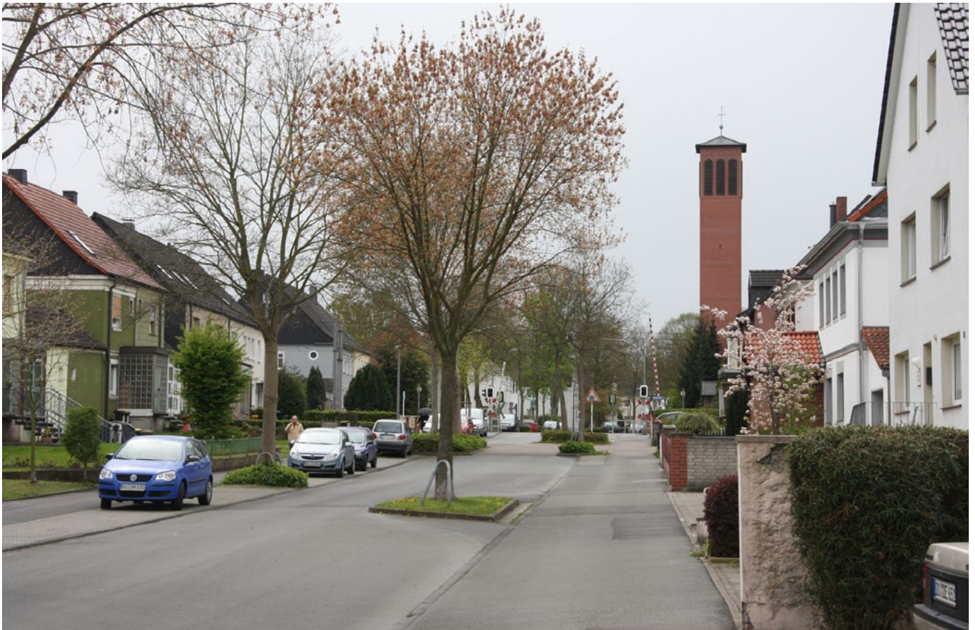
Uspokojenie ruchu z wykorzystaniem drzew zwężających jezdnię. Dortmund (Niemcy) fot. T.Bużatek
